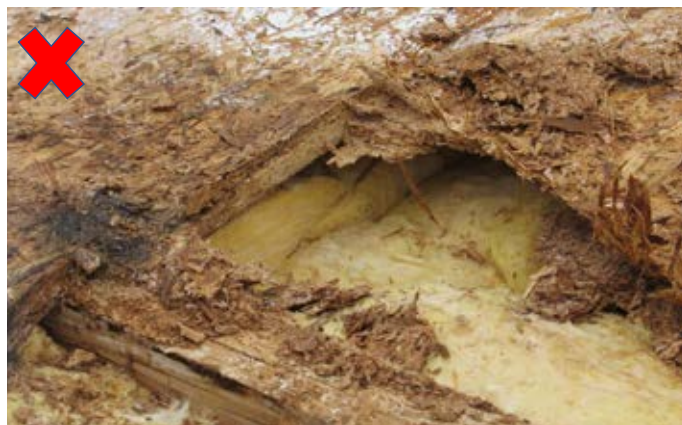
Obr. 6 Ukážka prejavu skondenzovanej vodnej pary v mieste materiálov na báze dreva
