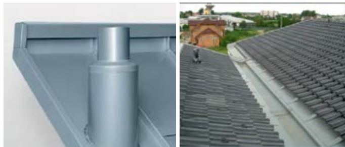
Obr. č. 3-4 Pájkovaný spoj: bodový prestup odvetrania kanalizácie. Realizácia medzistrešný žľab pájkovaný spoj – žľabová dilatácia, čielka, vpusť
