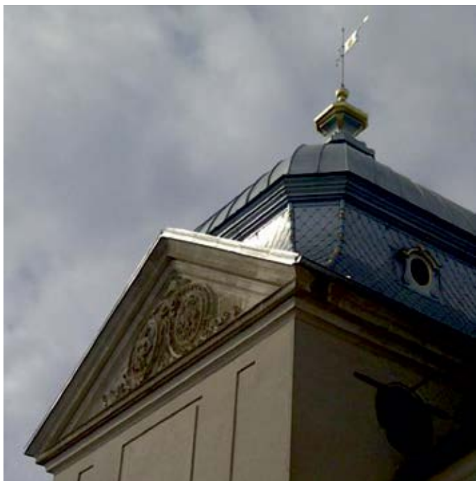
Obr. č. 18/b Zámok Halič: RHEINZINK prePatina walzblank, kombinácia dvojitá stojatá drážka, pod ozdobnou profilom maloformátové šablóny, spotreba 29 ks/m 2
