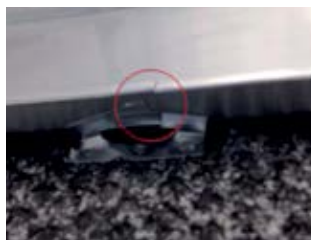
Obr. č. 20 Vetrom strhnutá metalická krytina. Posuvné príponky a prevedenie detailu odkvapu neodolali nárazovej sile vetra. Príponky sú doslova roztrhnuté v mieste behúňa, ktorý zabezpečuje dilatačný pohyb krytiny. Příklad z Nemecka.
