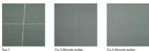
Obr. č. 2 Proces patinácie – obnova poškodeného povrchu
