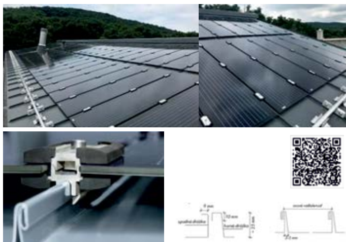
Obr. č. 16 RHEINZINK PV panel, Model 20 výkon cca 100 Wattpeak. Realizácia jún 2020 Bratislava. Detailný pohľad na kotviaci systémový klip. Vzdialenosť drážok na streche / raster: 430 mm
