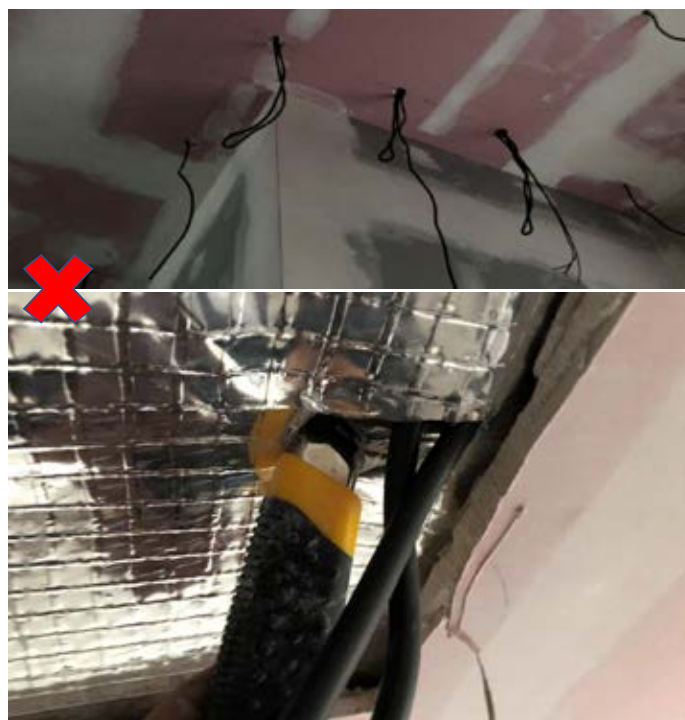
Obr. 5 Parozábrana v nevhodnej polohe priamo pod sadrokartónom a výrazne perforovaná elektroinštaláciou bez utesnenia
