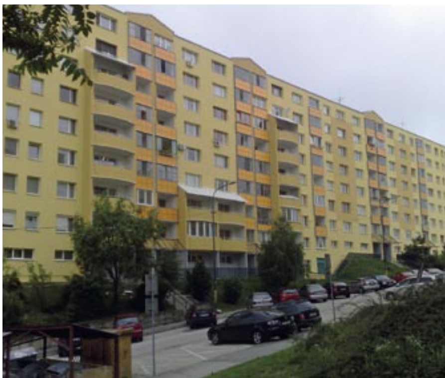
Dom na ulici Jána Stanislava 1 – 11 na Dlhých dieloch v Bratislave
